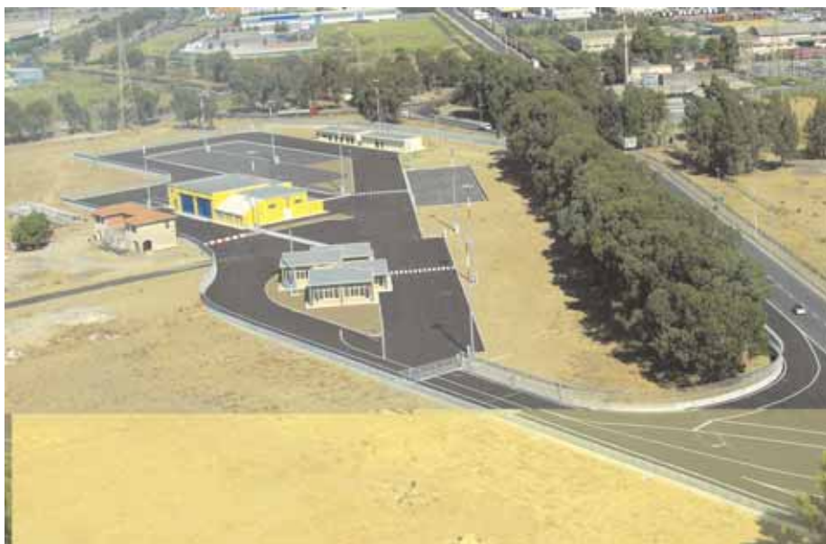
Sopra, uno stralcio dell'Area di sosta dell'Interporto di Catania
