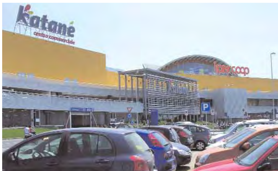
In alto, auto parcheggiate in via Quasimodo. Sotto, il muro di contenimento dell'Ipercoop, costruito a poca distanza da uno degli edifici del Circolo didattico "Gianni Rodari" di San Paolo (visibile sulla destra)
