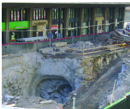
Alcuni scatti fotografici del corso Sicilia: in alto il chiosco che ha dato adito a molti malumori. Sotto, una vista del cantiere per la Metropolitana.
